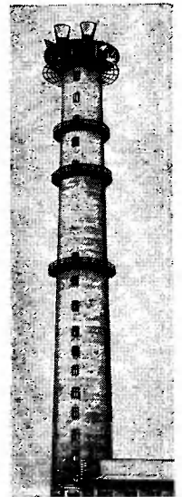
Башня радиорелейной станции с установленными на ней рупорно-параболическими антеннами
