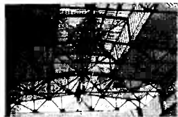
К ст. Асбестоцементные изделия. Покрытие цеха из асбестоцементных плит размером 6 × 15 м
