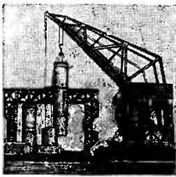
Сооружение фундамента опоры моста из сборных железобетонных оболочек
