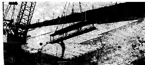
К ст. Берегоукрепительные сооружения. 1. Морские буны. 2. Волнобойная стена, защищённая наброской из фигурных массивов. 3. Укрепление берега железобетонными плитами
