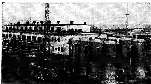
Газокомпрессорная станция (на переднем плане — блок пылеуловителей)
