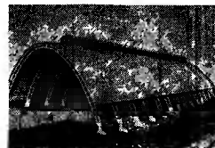
Промышленное здание, построенное с применением сборных железобетонных решётчатых арок (Венгрия)
