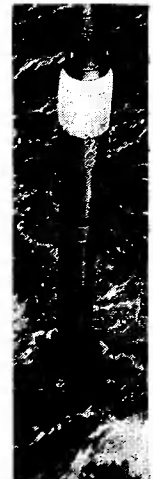
К ст. Линия связи. Спуск в воду подводного кабеля с промежуточным усилителем электрических сигналов
