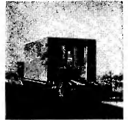
К ст. Блок объёмный. Транспортирование блока на строительную площадку
